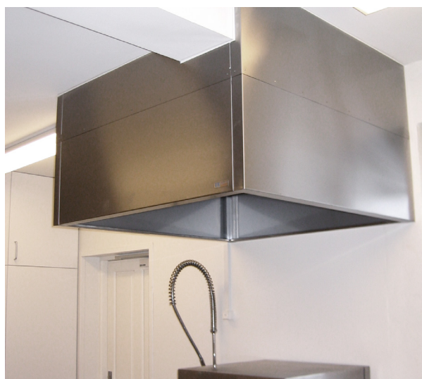
Emhætte model VKE-SP, før montering af spaltesug
